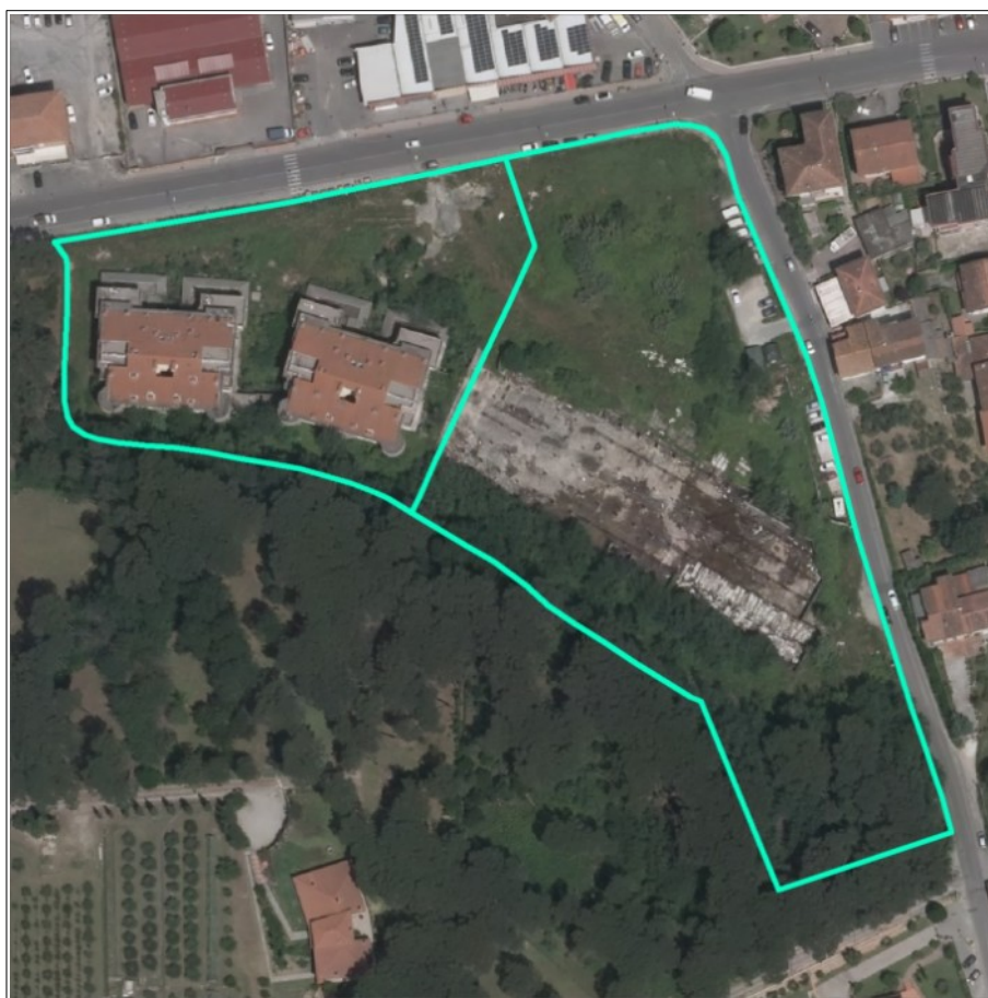
Area di rigenerazione urbana R5.2 – Visione aerea
